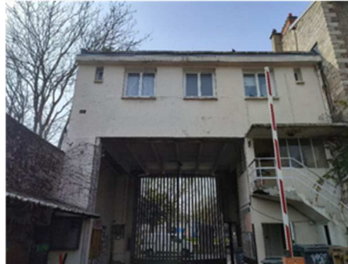
Cas d'un bâtiment peu performant (bâtiment 8)
